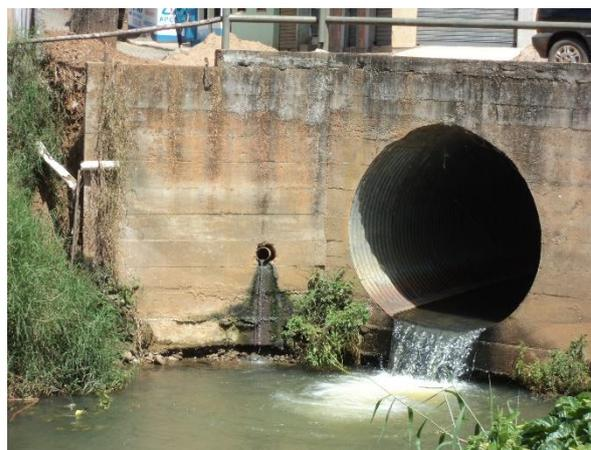
FIGURA 16— LANÇAMENTO DE ESGOTOS SANITÁRIOS *IN NATURA*
