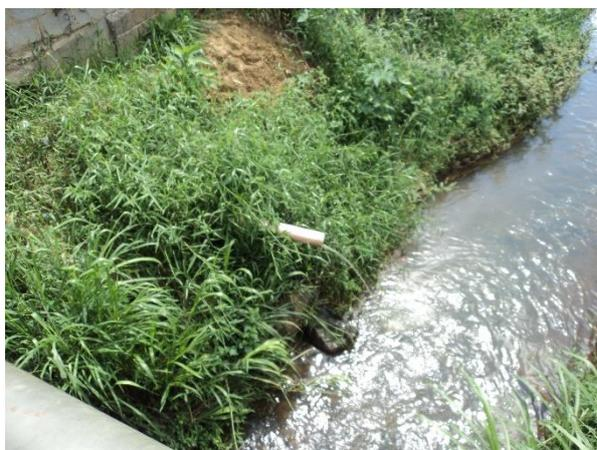
FIGURA 15— LANÇAMENTO DE ESGOTOS SANITÁRIOS *IN NATURA*
